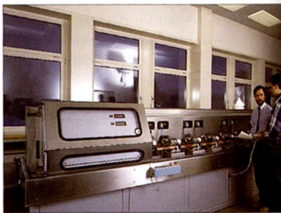
Wärmezähler-Prüfstelle der Salzburg AG
