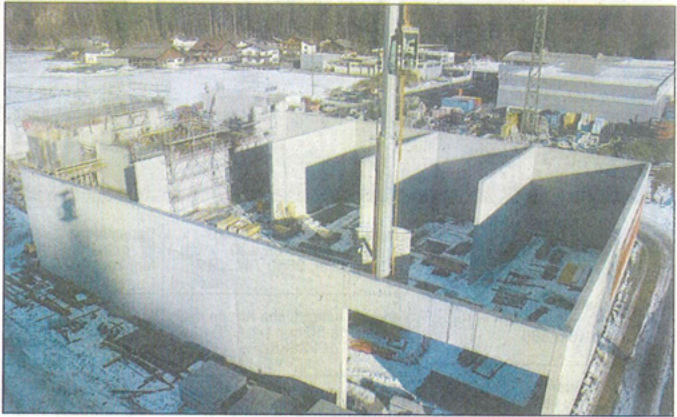
Die Bauarbeiten am Biomasse-Heizkraftwerk „Naturwärme Montafon“ laufen auf Hochtouren.
