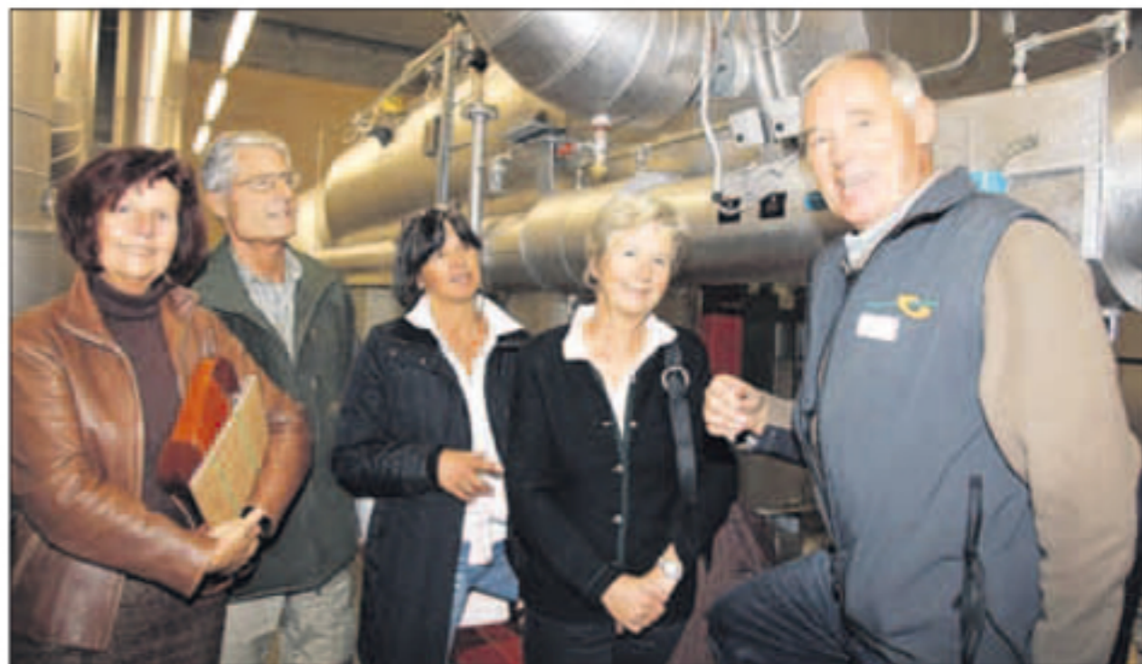
Über 1500 Interessierte blickten hinter die Kulissen der Naturwärme Montafon. (Fotos: meznar-media.com)
