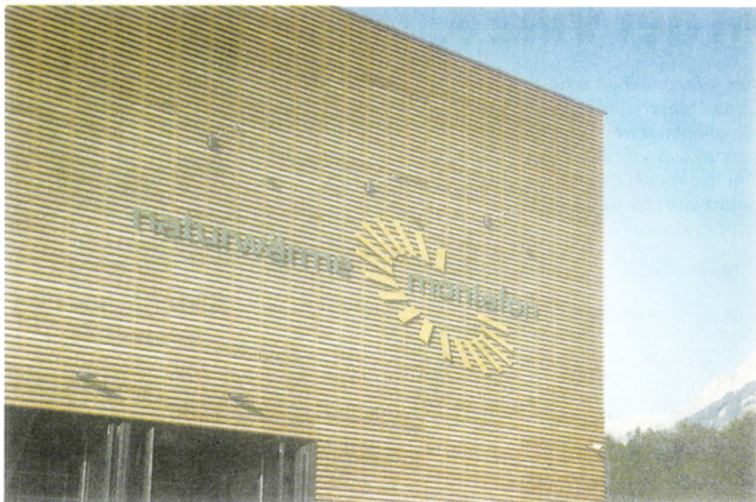
Interkommunales Großprojekt Naturwärme Montafon geht mit einem Tag der offenen Tür ans Netz.
