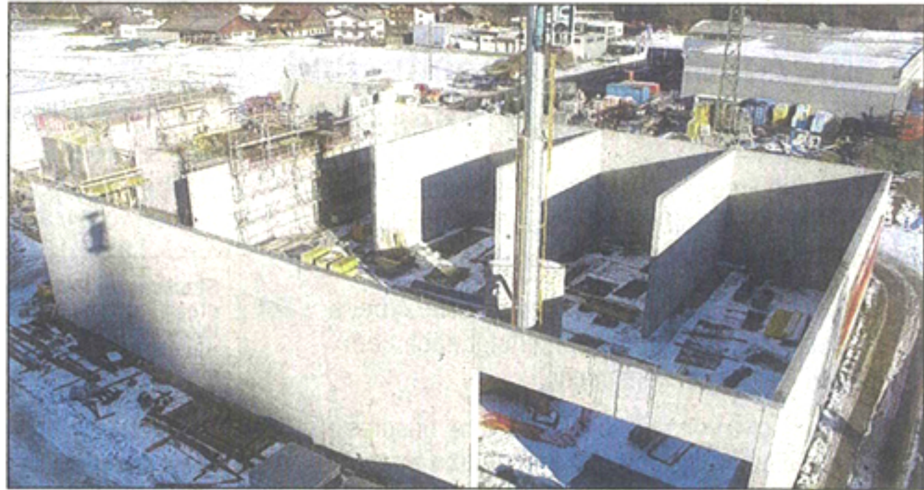
Die Bauarbeiten für das Naturwärmekraftwerk Montafon laufen auf Hochtouren.
