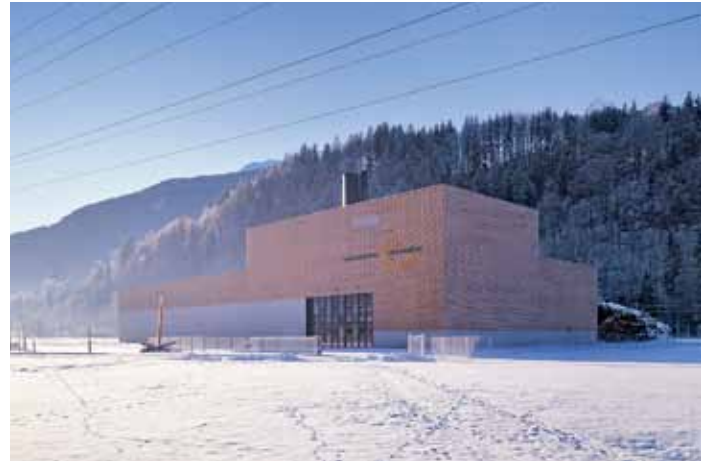
Heizkraftwerk in Schruns: Bei der Naturwärme Montafon werden mehr als 20 GWh/J Wärme und 3 GWh/J Strom erzeugt
